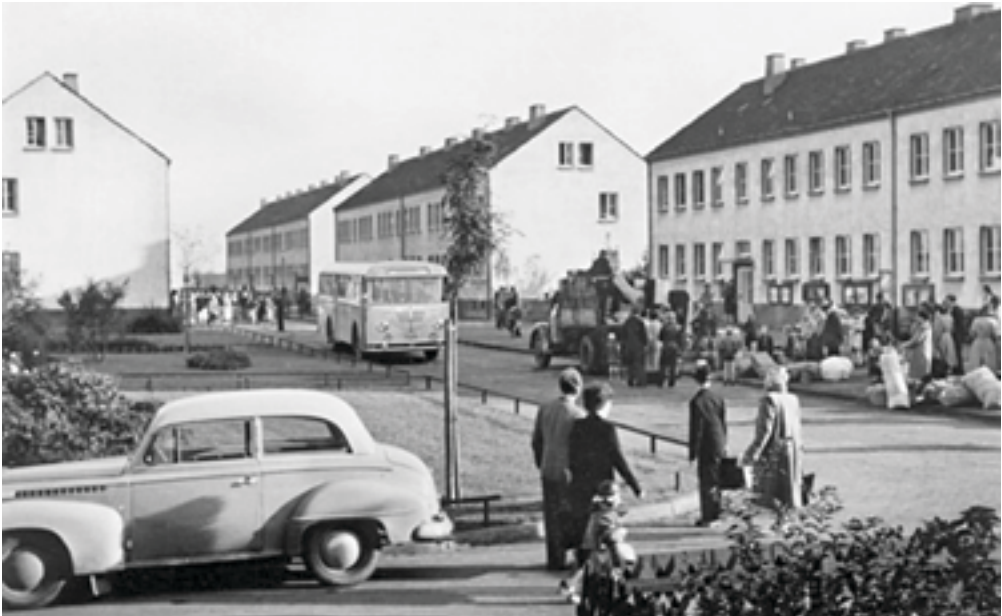
Die Strukturprobleme werden noch verschärft durch die vielen Flüchtlinge und Vertriebenen (hier ein Blick in die heutige Landestelle Unna-Massen).
